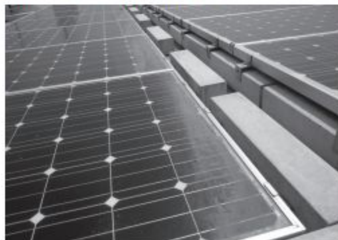
図3 パネルの汚れによる発電量低下
